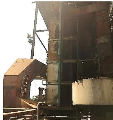
Al existir esta combinación de aire-gases una cierta cantidad de ceniza queda depositada en los baffles de circulación de aire ocasionando más daño en los tubos y daño en los baffles.
